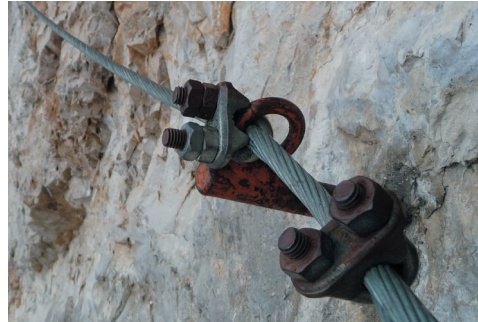
Verankerde staalkabel voor het zekeren en als hulpmiddel bij het klimmen.
