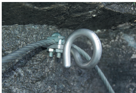
Een zogenaamde 'varkensstaart' waar een extra zekeringsstouw in kan worden gehangen.
