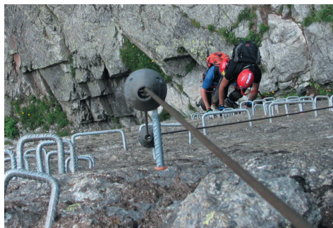
Op de staalkabel is een plastic stopper gemonteerd om beschadiging van karabiner én bevestigingspunt te voorkomen.
